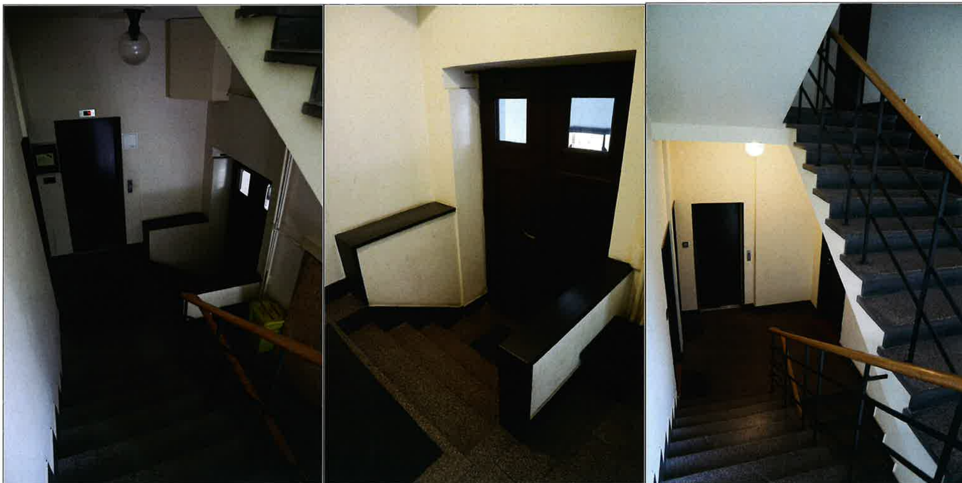
Widok na wnętrze podestu na parterze w klatce schodowej A oraz biegi schodów.
