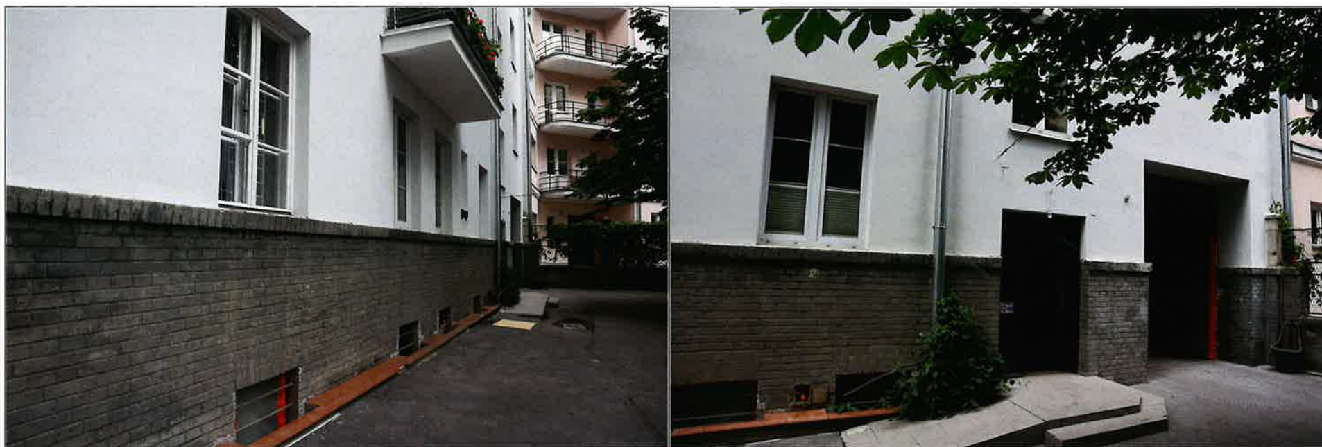
Widok części parteru elewacji podwórzowej skrzydła od strony ul. Barskiej oraz przejazdu bramnego i bocznego wejścia do klatki schodowej A.
