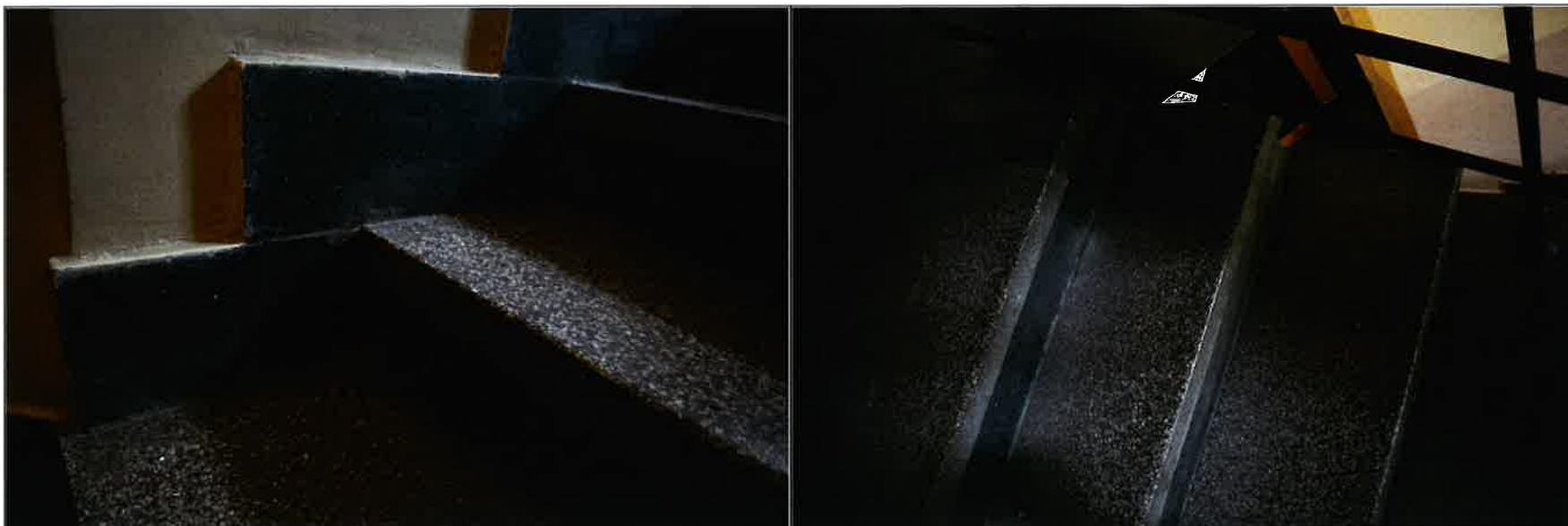
Schody – przykłady zastosowanego lastyko.
