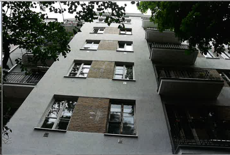
Fragment pseudoryzalitu i balkonów od strony ul. Barskiej.
