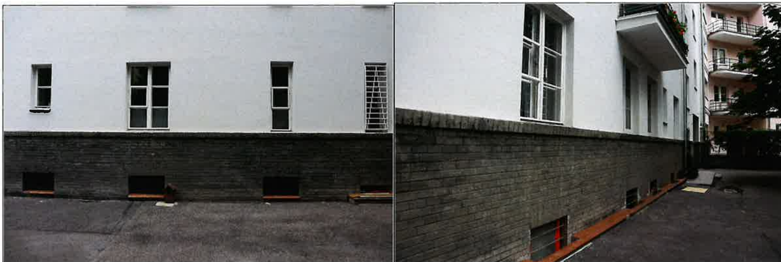
Widok cokołu w elewacjach od strony podwórza.
