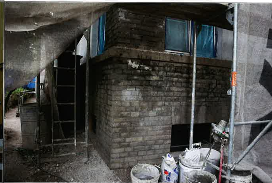
Cokół z cegły silikatowej (przed pracami konserwatorskimi).
