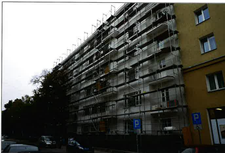
Widok ogólny od strony ul. Kaliskiej (w trakcie remontu elewacji).
