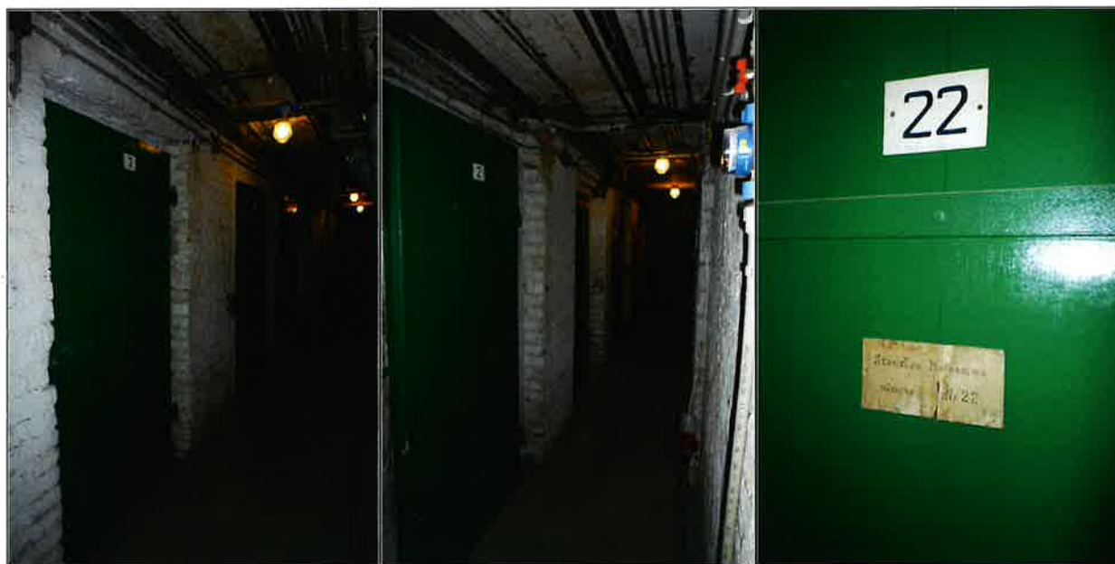
Korytarz w piwnicy, zachowane oryginalne drewniane drzwi, na niektórych przedwojenne kartki z nazwiskiem lokatorów.
