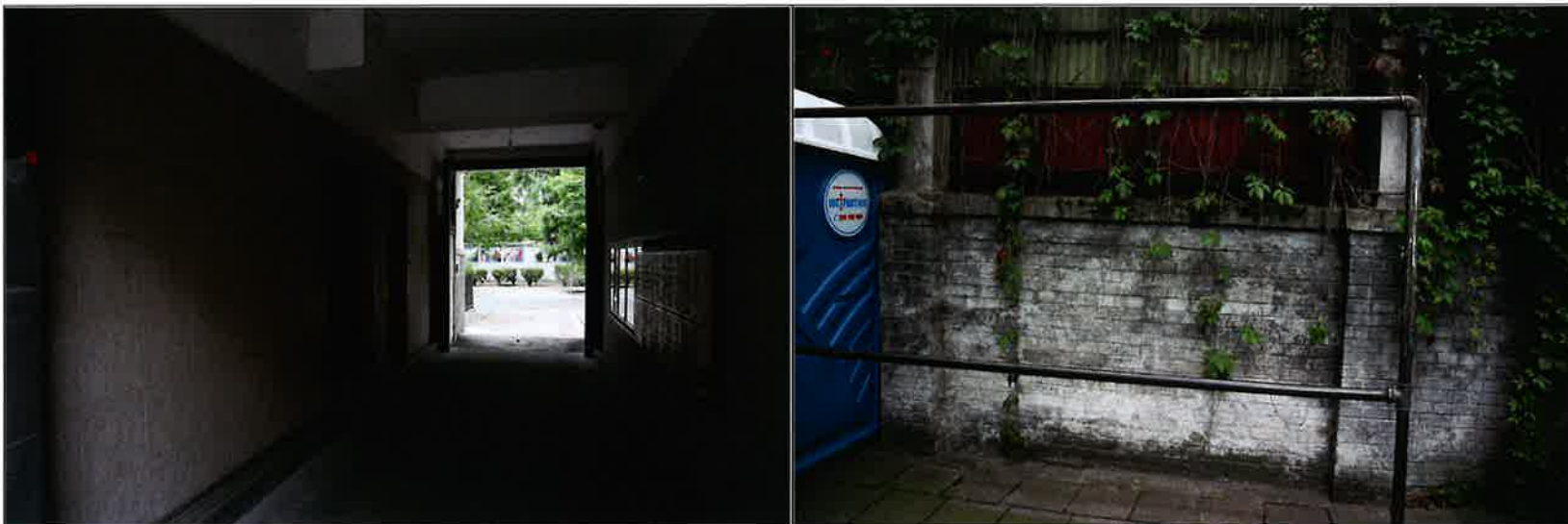
Widok przejazdu bramnego od strony podwórza. Fragment muru z cegły silikatowej, oddzielającego podwórze od sąsiednich posesji.
