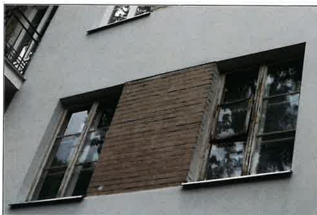
Przykłady zachowanej zabytkowej stolarki okiennej oraz balkonowej, oraz metalowej balustrady na balkonie.
