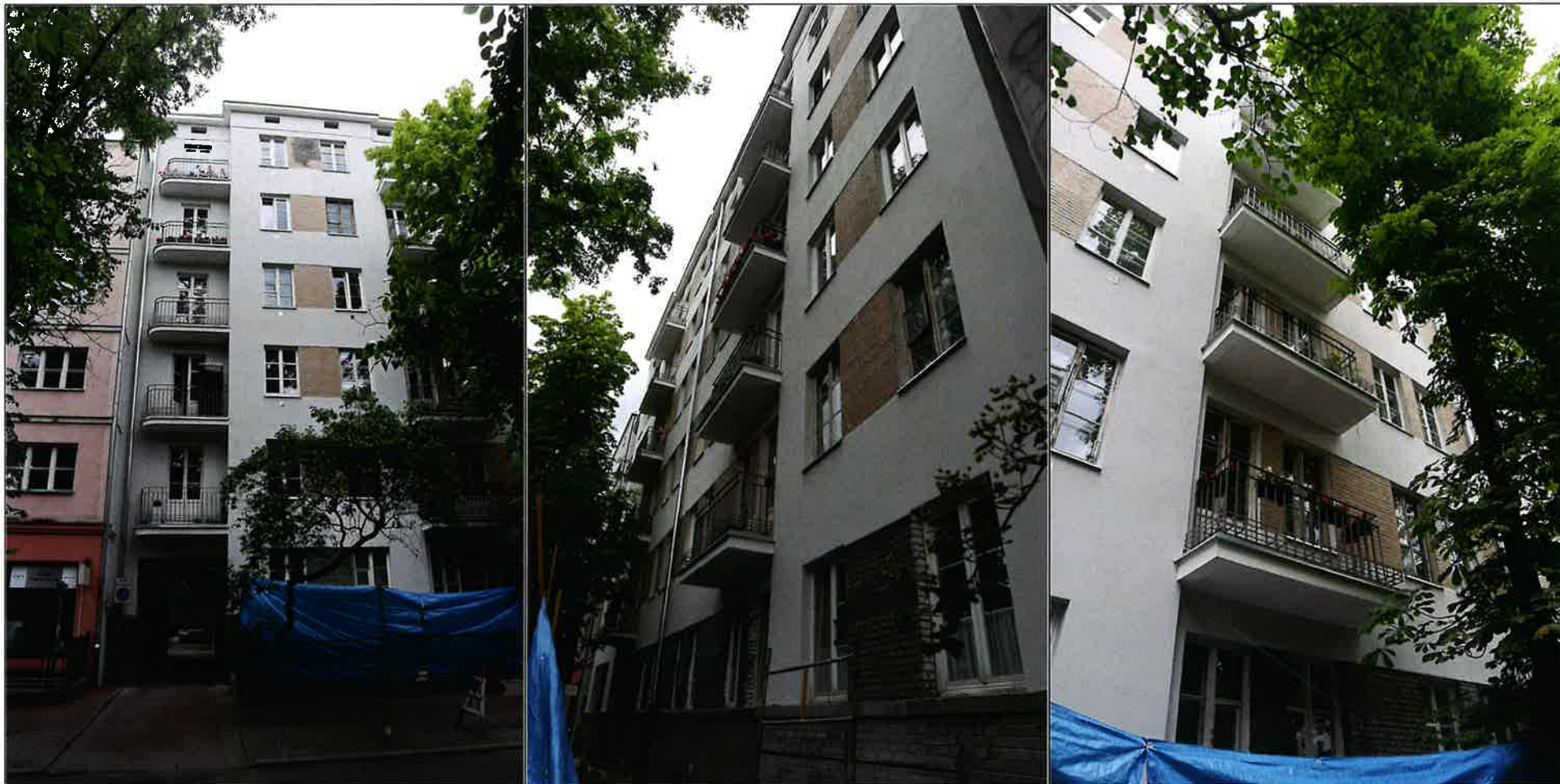
Widok fragmentów elewacji frontowej od strony ul. Barskiej.
