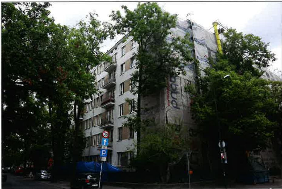
Widok ogólny od strony narożnika ul. Barskiej i Kaliskiej.
