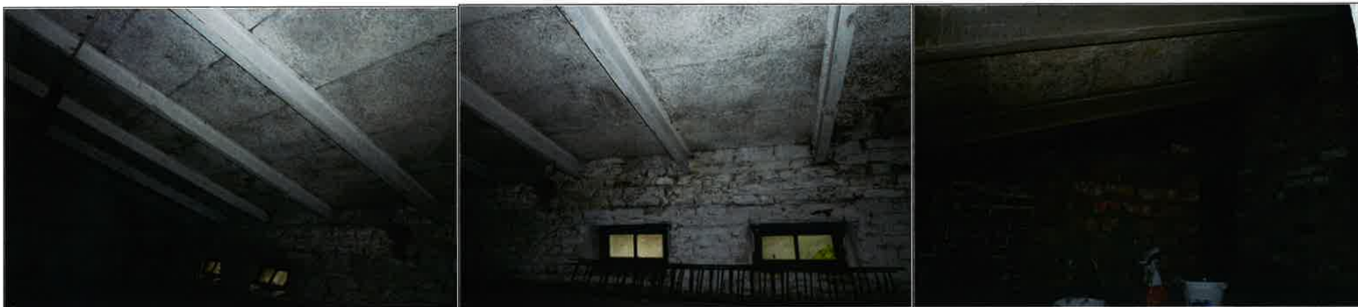
Widok części nieużytkowej na poddaszu. Współczesna, metalowa konstrukcja dachu, z wypełnieniami z supremy między belkami.
