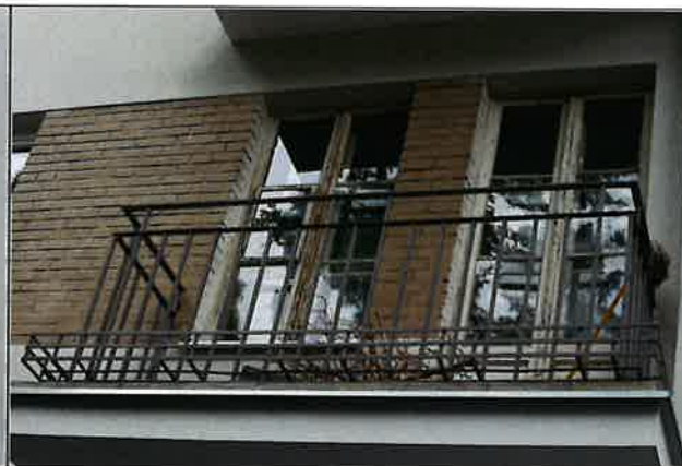
Przykłady zachowanej zabytkowej stolarki okiennej oraz balkonowej, oraz metalowej balustrady na balkonie.
